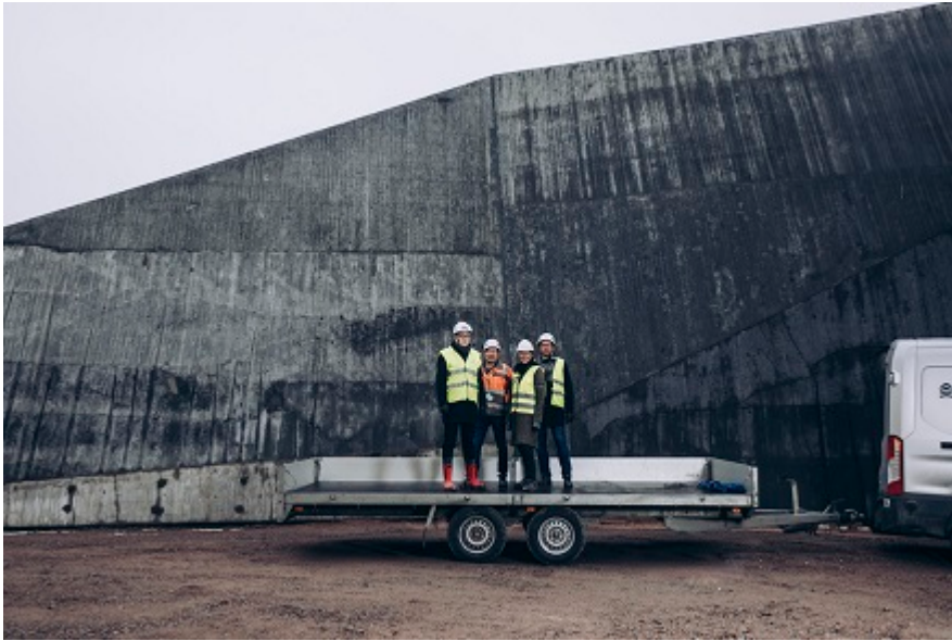
Maisema-arkkitehtitoimisto Maanlumon, Arkkitehtitoimisto HLP:n sekä Kuvanveistäjä Pertti Kukkosen Valaskala-betoniveistökseksi muuttama ilmanvaihtokanava kaupunkikeskuksen edustalla.
